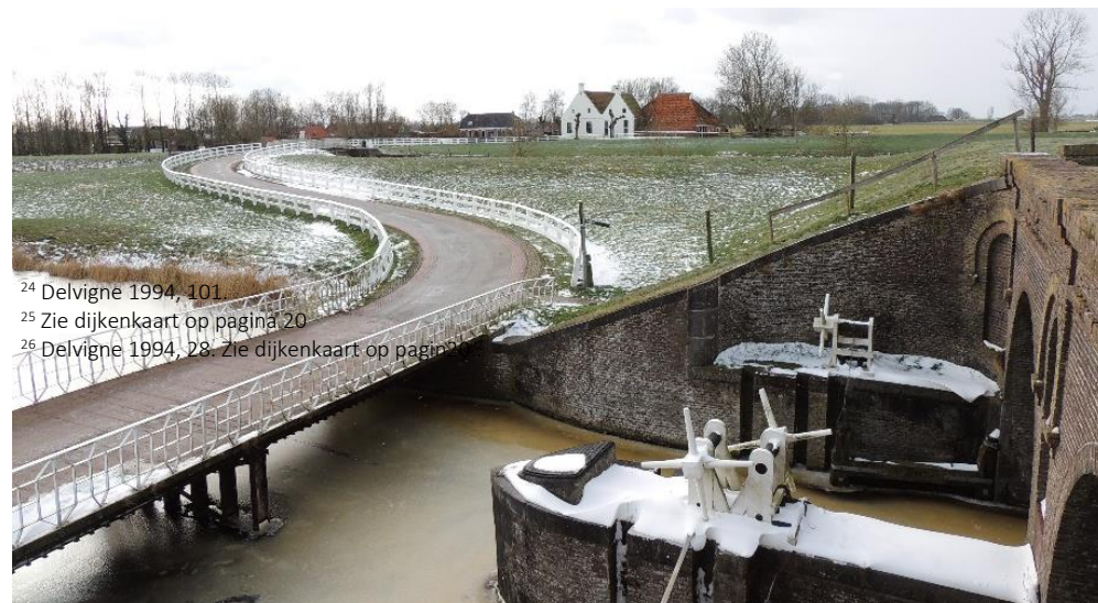
Figuur 7. Langs een fraaie natuurlijke bocht van het Reitdiep liggen de sluizen van Aduarderszijl. Ze werden in 1706 en 1867 gebouwd om overtollig water uit het achterland te lozen op het Reitdiep. Dit diep stond tot 1877 in open verbinding met de zee. Foto: J. Wiersma.
