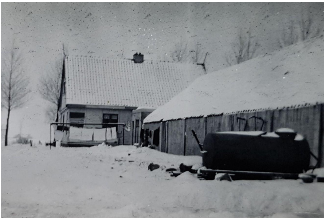
Houten noodwoning (1952) en noodstalling (1949) na de brand
