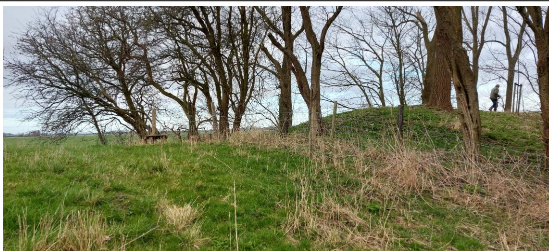
2024 / zie verschil met oorspronkelijke hoogte van de dijk
