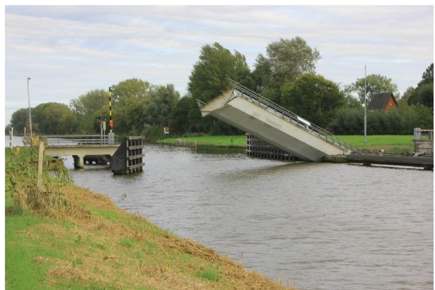
De PP-brug na de aanvaring / september 2018
